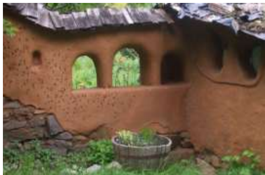
Fig. 5 Muros de Cob
