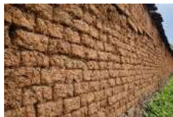
Fig. 2 Tabique de adobe
