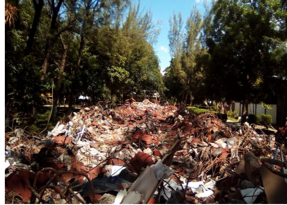
Fig. 11 Restos de 10 Aulas
