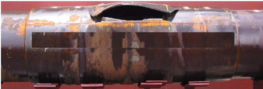
Figura 9. Envoltura de contacto, fractura la sección reparada.
