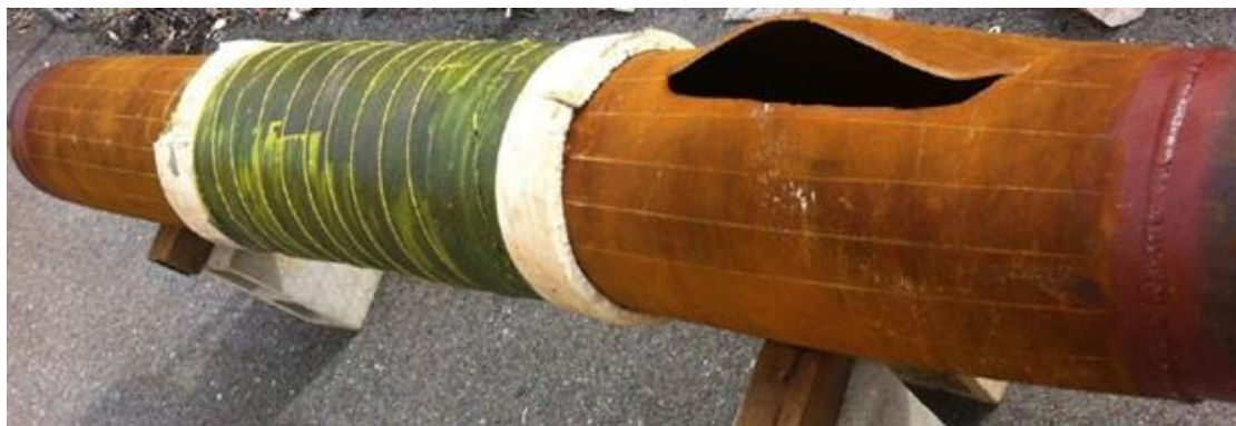
Figura 10. Envoltente de material compuesto, fractura la sección no reparada.
