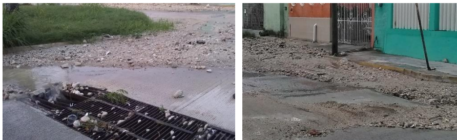
Figura 8. Arrastre de material, Circuito Pablo García Este en la colonia de Cd. Concordia. Fuente: Propia.
