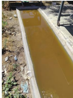
Figura 5 Laguna de Evaporación
