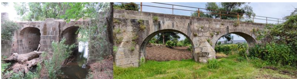
Figura 1. Obras de infraestructura hidráulica construidas durante el período de Joseph Ruíz de la Rabia. Fotografías: Dante B. Martínez
