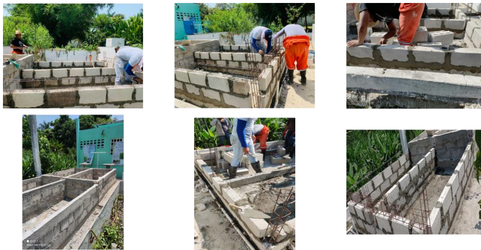
Figura 3. Proceso de Construcción de los Humedales.
