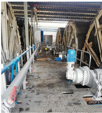
Figura 7. Rehabilitación de biodiscos.
