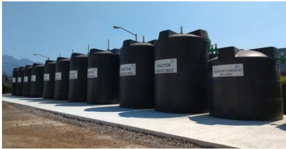
Figura 1. Nueva etapa a base de reactores anaerobios.
