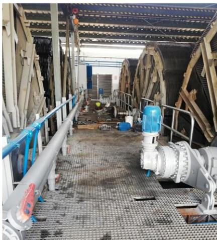
Figura 7. Rehabilitación de biodiscos.
