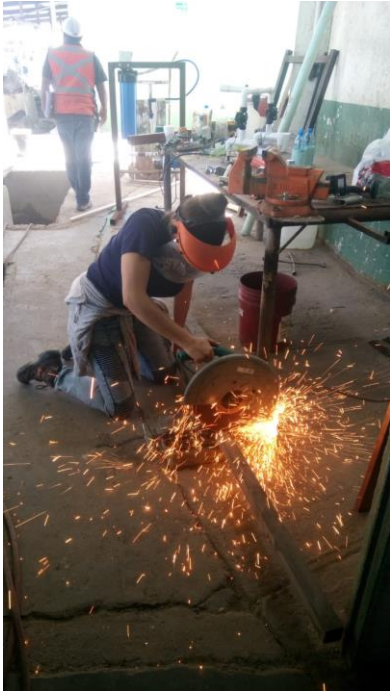
Figura 2.- Fabricación de estructura. Fuente propia.
