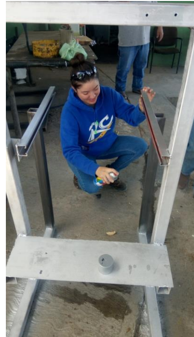
Figura 1. Detallado de estructura. Fuente propia.
