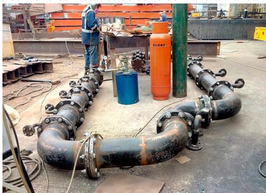
Figura 1 Spool de tuberías.
