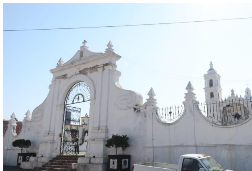
Fig.2. Acceso y barda perimetral del atrio
