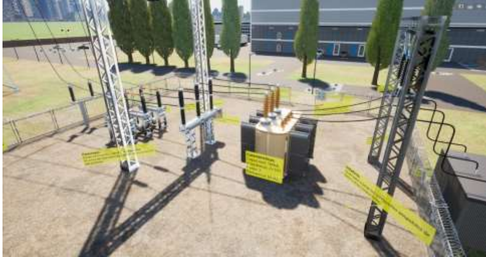
Figura 4. Vista área de la subestación eléctrica en el recorrido en realidad virtual.
