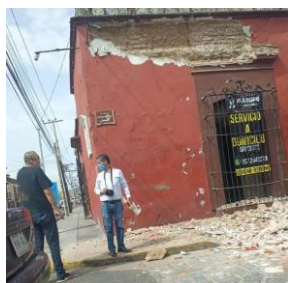
Figura 6. Daños en los acabados del inmueble de un negocio ubicado en Oaxaca. Fuente: Usuario de redes sociales
