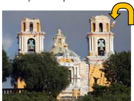
Fig. 18. Caída de Pináculo en cúpula de Torre Sur.
