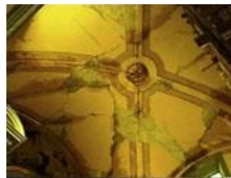
Fig.2 Bóveda de Arista T. de San Antonio
