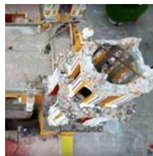
Fig. 19. vista aérea de la torre norte
