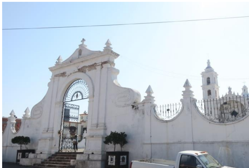
Fig.2. Acceso y barda perimetral del atrio
