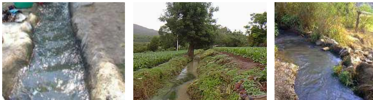
Fig. 3 Diferentes vistas de la zanja o canal principal de riego.
