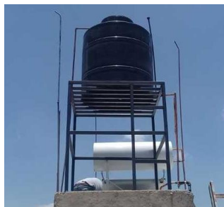
Figura 7. Ejemplo de tinaco elevado. (habitissimo, 2020).
