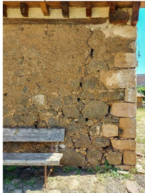
Fig. 7 Fractura en muro de la sacristía. Fotografía: ASS.
