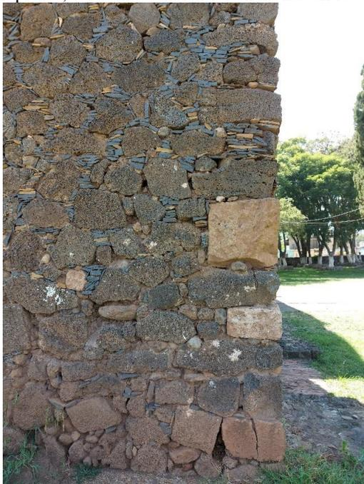
Fig. 6 Fracturas en cadena de ángulo de la torre. Fotografía: ASS.
