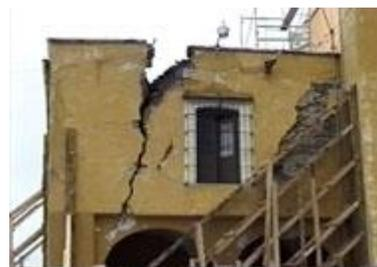
Fig. 14. Desplome en 2o. Piso muro
