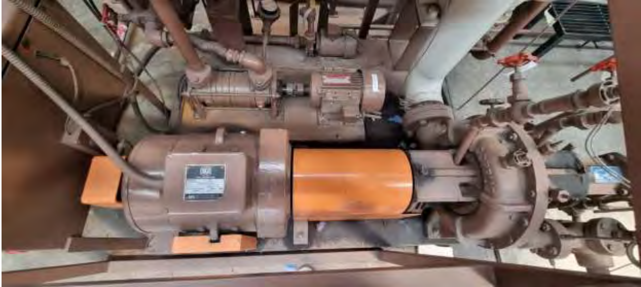
Figura 1. Turbina de vapor de marca Coppus de potencia 9.06 HP instalado en laboratorio.
