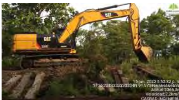
Imagen 2. Observación directa. Elaboración propia (Desmantelamiento)
