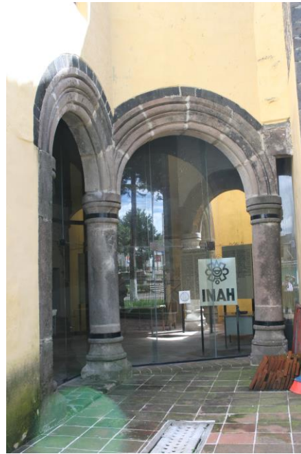
Fig. 2. Acceso a la Capilla Abierta
