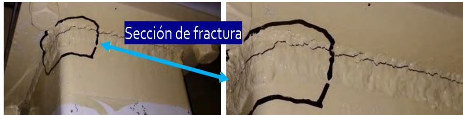
Figura 4. Falla de los soportes del robot.
