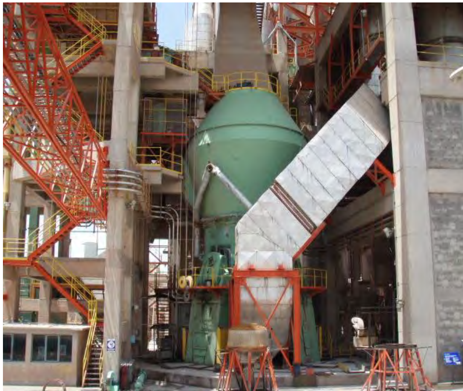
Figura 1. Molino Vertical de Materia Prima Marca Loesche.
