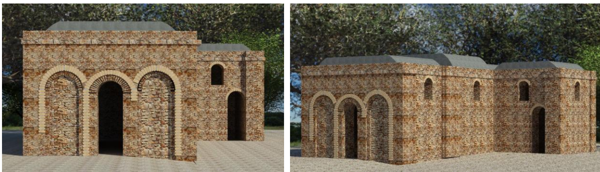
Figura 8. Modelos 3D del santuario actual de la Casa de la Virgen María en Éfeso, vistas frontal y esquinada donde son notables las estructuras de los muros de carga de piedra y arquerías de medio punto. También son notorias las bóvedas esquifadas en la cubierta. (Elaboración propia, 2021)
