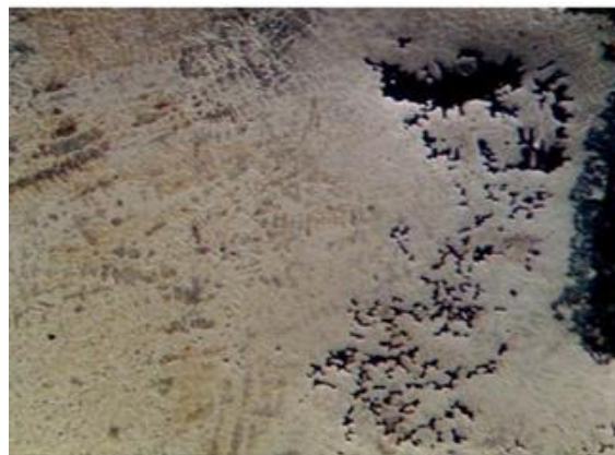
Ilustración 5 - Corrosión intragranular posterior al proceso de reparación
