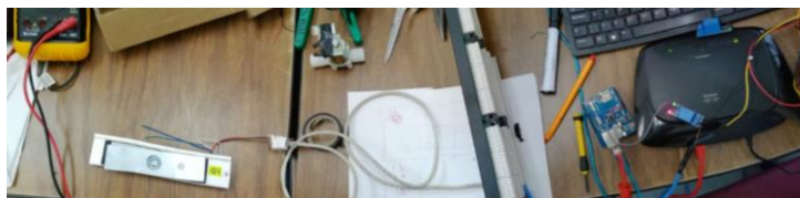
Fig. 11. Prueba de conectividad y alimentación con cerradura magnética de 12V.
