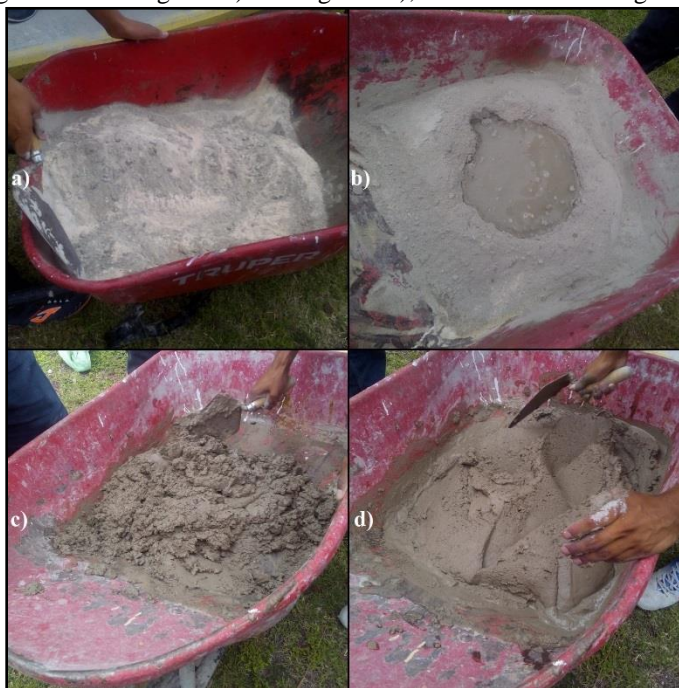
Figura 2. Obtención de la mezcla: a) Vertido de los compuestos; b) Vertido de agua; c) Mezclado; d) Mezcla final
