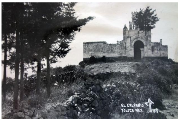
Figura 2. Fachada de la Capilla de Nuestro Señor del Calvario con la barda atrial original. Probablemente hacia el Siglo XIX. (Anónimo)
