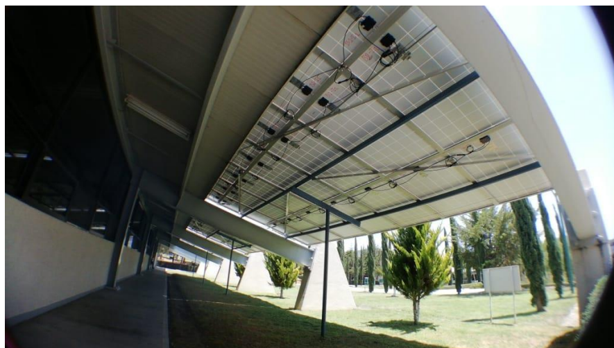
Figura 4. Instalación de los paneles fotovoltaicos.
