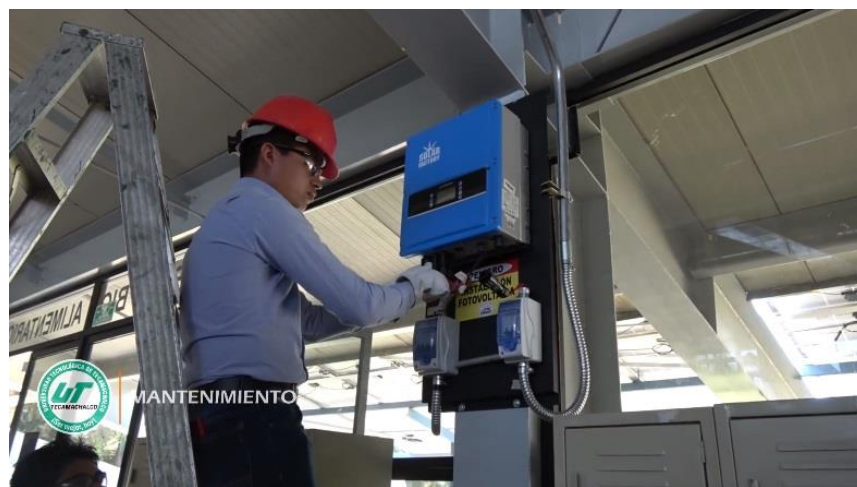
Figura 5. Instalación del sistema de control de los paneles fotovoltaicos.
