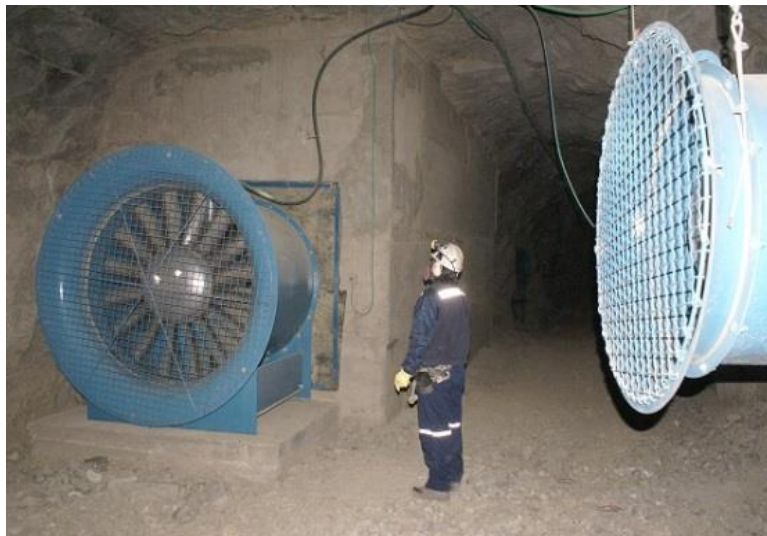
Figura 3.- Ventilador industrial en mina
