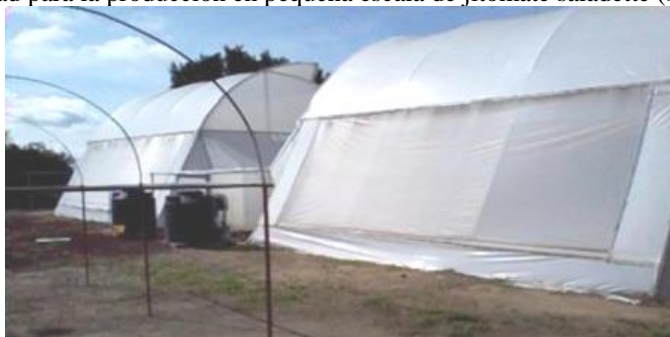
Figura 1. Invernadero tipo baticenital
