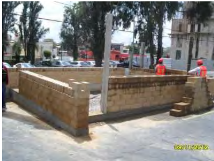
Fotografía 1. Muros dobles de adobe tecnificado
