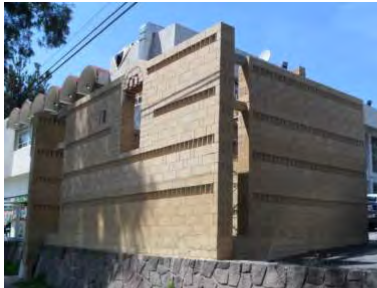
Fotografía 2. Texturas y colores naturales en los muros de adobe tecnificado FUENTE: Elaboración propia
