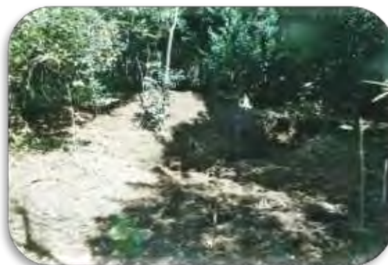
Fig. 16. Excavación para colocar el biodigestor.
