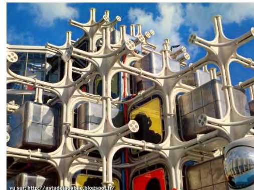
Fig. 1 Takara Beautillion, Kisho Kurokawa (1970) La modulación espacial es obtenida mediante la implementación de un sistema estructural que permite su libre multiplicación.
