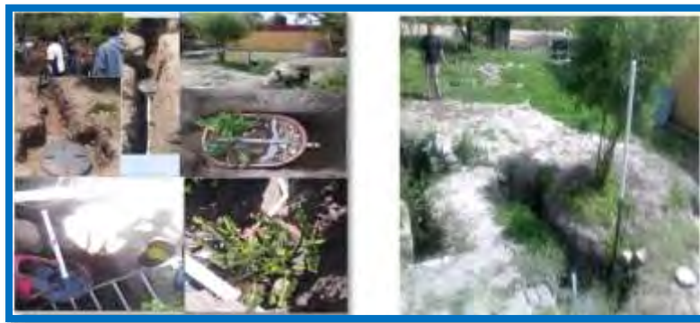
Figura 6. Fotos de construcción e instalación del Sistema de biodigestor y humedal artificial.
