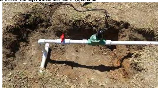
Figura 2 Llave de toma de agua y electroválvula hacia la zona de riego
