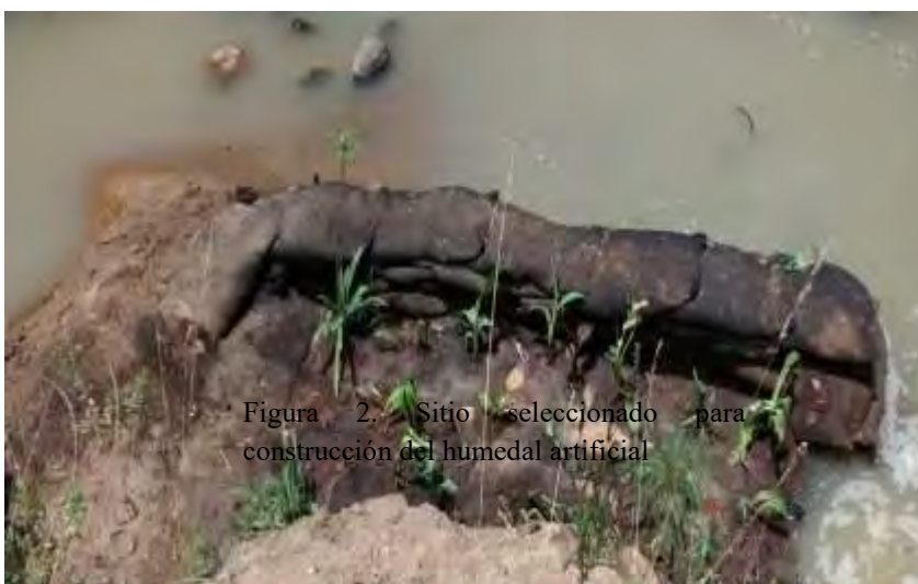
Figura 3. Humedal artificial construido con geocostales
