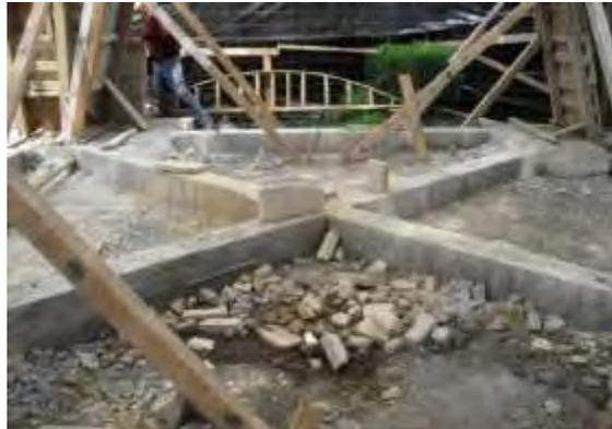
Figura 2. Reforzamiento de zapatas y en la diagonal
