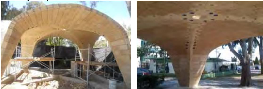
Figuras 9 y 10. Sistema constructivo en el interior de la bóveda y detalles en las aristas.
