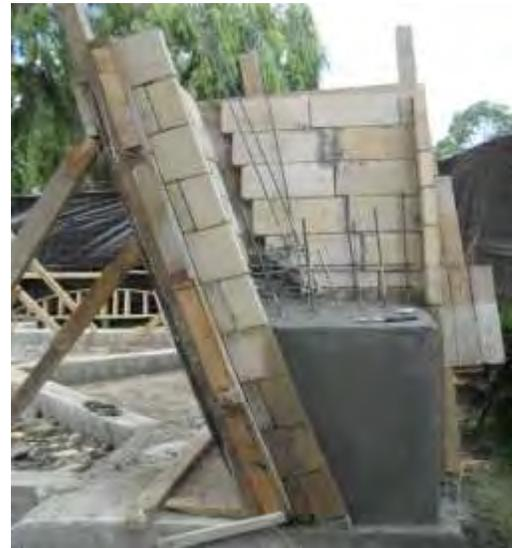
Figuras 3 y 4. Sistema de armado de los dados de contención
