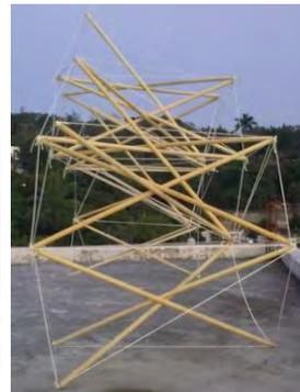
**Figura.-6 y 7.** Módulos de tensegrity repetidos ensamblados en forma de arco. Fuente Miguel Diaz, Ramiro Tello. Año 2013
