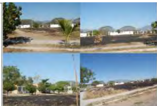
Imagen 8. Condiciones actuales de áreas de cesión y áreas verdes. Se nota el descuido, falta de mantenimiento y de equipamiento. (Foto archivo personal).
