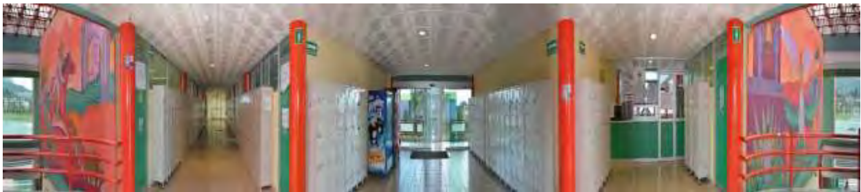
Figura 6. Panorámica, planta alta edificio A.
