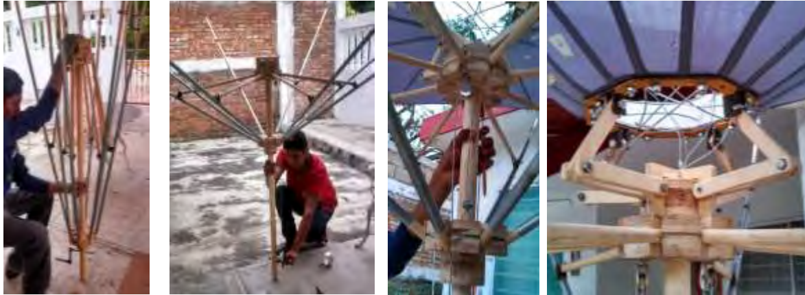
Figuras.-19 al 22. El modelado del paraguas retráctil ayudó a generar detalles constructivos más exactos para su óptimo funcionamiento al desplegarlo, Fuente: Morales (2013).
