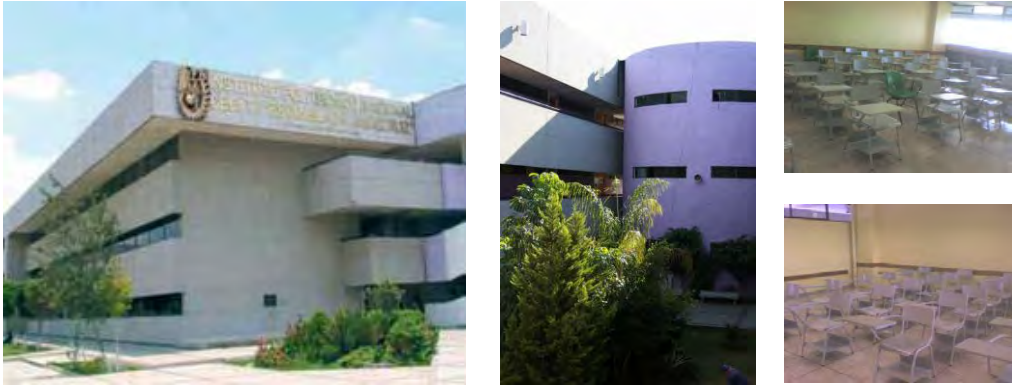
1. Edificio de aulas lado A exterior, jardín interior lado B e interior de aulas.
