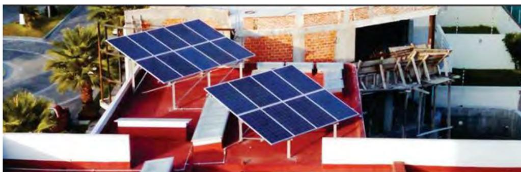
**Figura 7. Imagen del sistema fotovoltaico instalado.**
