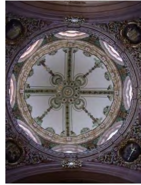
Figura 12. Interior cúpula octagonal en S.L.P.
