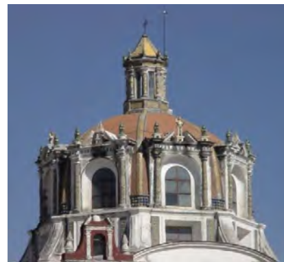
Figura 10. Tambor y cúpula octagonal en Puebla.
