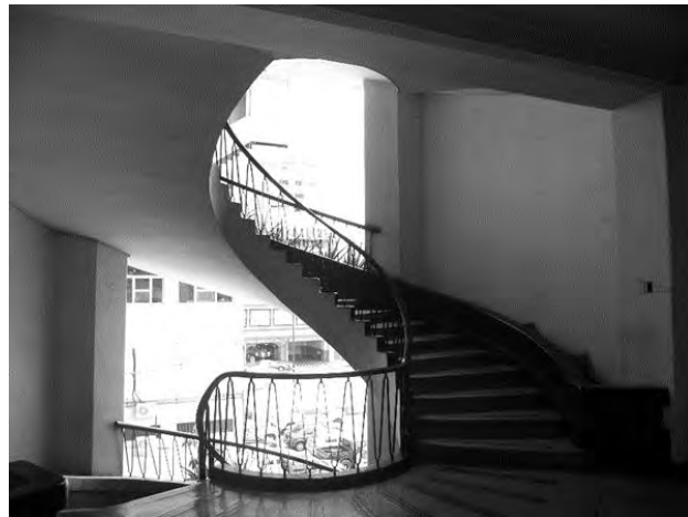
Figura 5. Area de circulación vertical: escaleras
