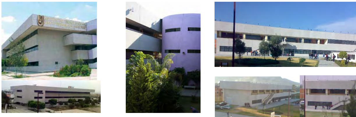
1. Edificios de aulas lado A exterior, jardín interior lado B y aulas en edificio de laboratorios pesados.
