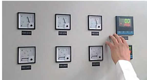
Figura 4 Ingreso de parámetros en control de presión en prensa 3000T.
