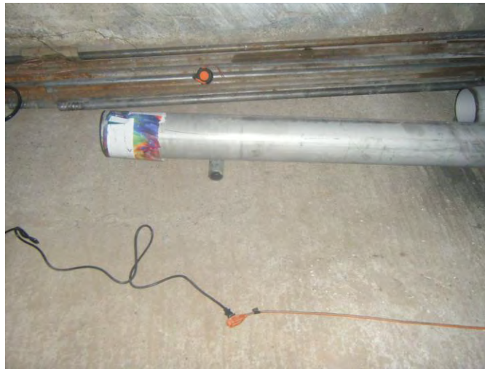
Figura 3. Construcción del ducto T
