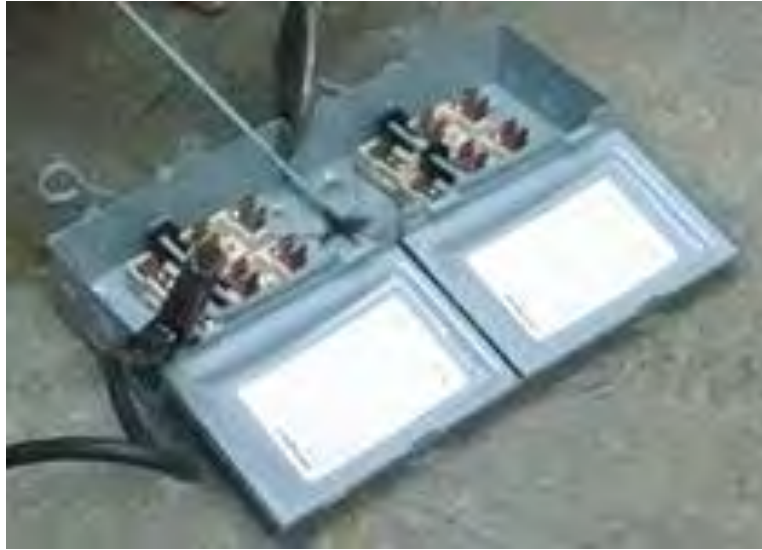
Figura 2. El resultado de la unión de la caja de fusible.
