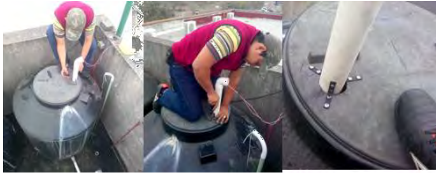
Fig. 11. Colocación física de tubo con sensores de nivel
